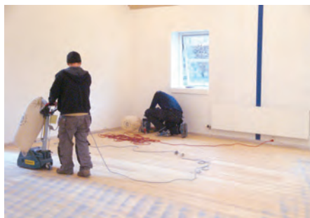
Renovering af storstuen.
